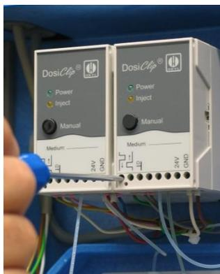
Uma bomba que não funciona corretamente causa valores de medição incorretos (por exemplo, mensagem de erro "36 Falha análise"). Em caso de problemas com a bomba doseadora, recomendamos substituí-la por uma bomba de substituição.
