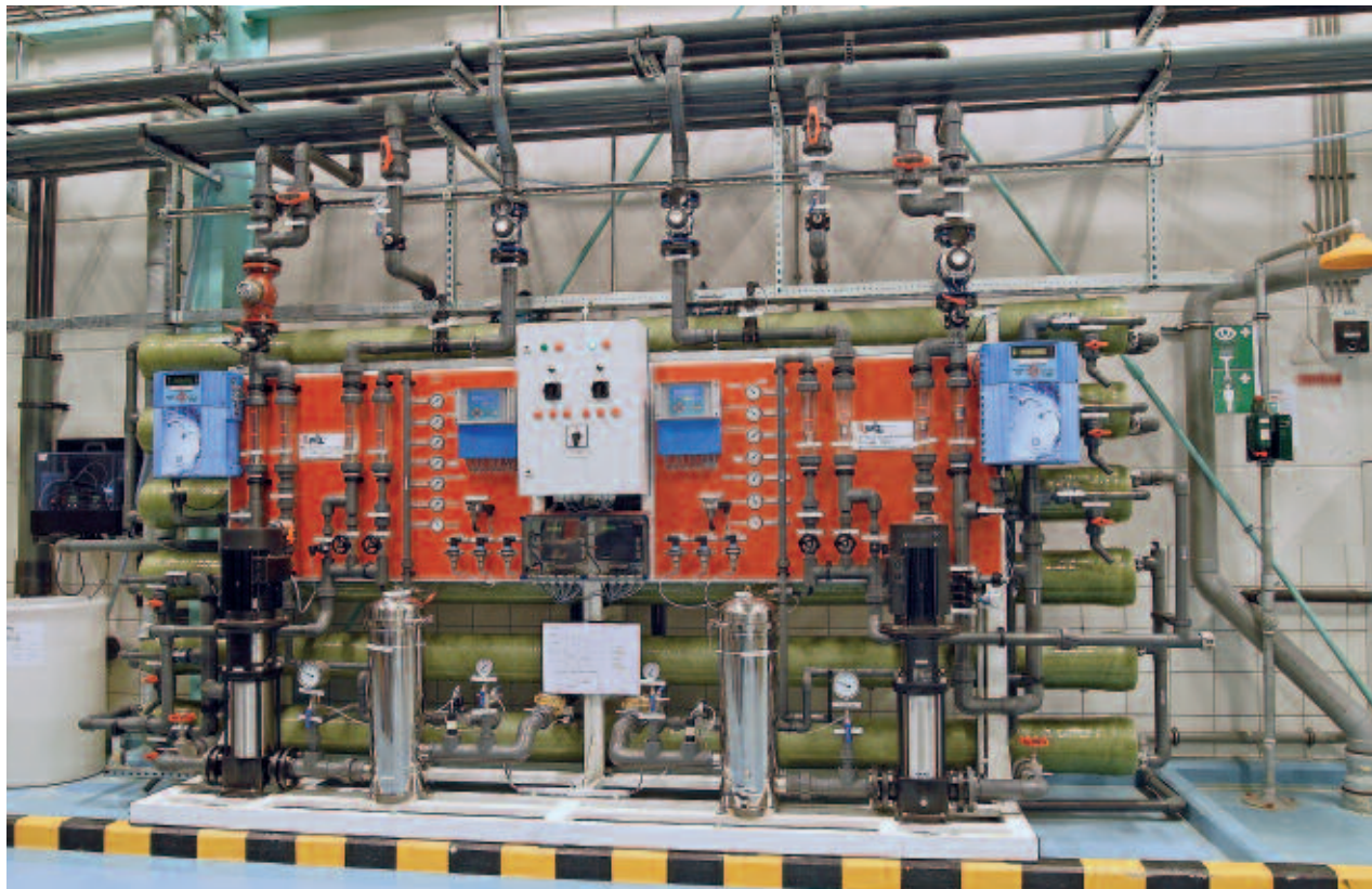
Installation de nano filtration avec les instruments Testomat® et Softmaster® intégrés dans une entreprise de transformation des produits alimentaires danoise
