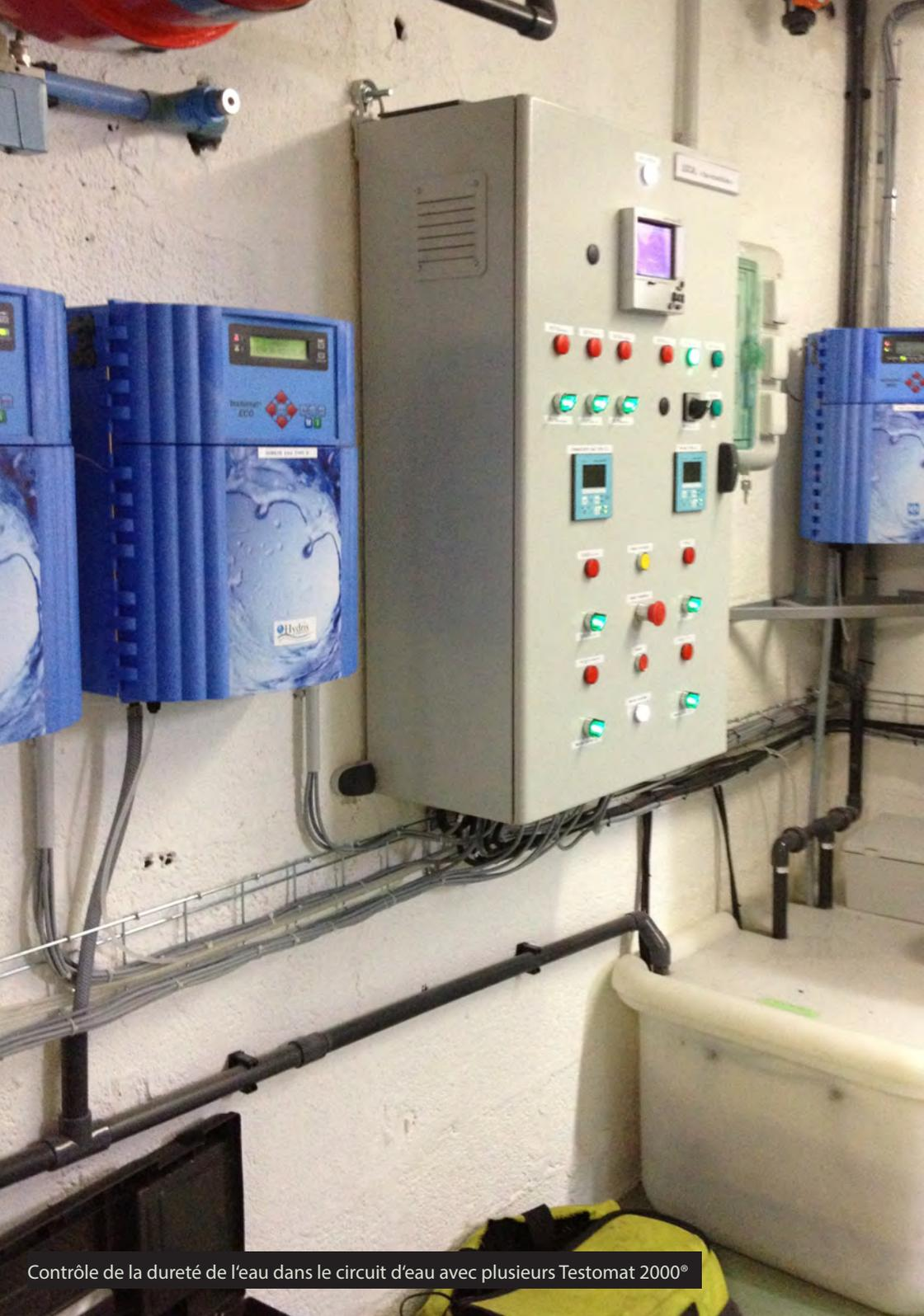
Contrôle de la dureté de l'eau dans le circuit d'eau avec plusieurs Testomat 2000®
