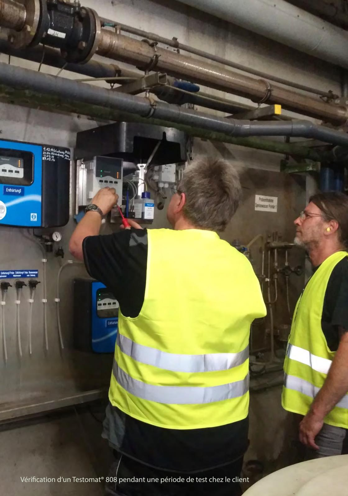
Vérification d'un Testomat® 808 pendant une période de test chez le client
